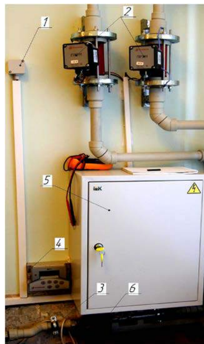
Рисунок 1 - Внешний вид экспериментального образца системы мониторинга и управления энергопотреблением: 1 – датчик внутренней температуры, 2 – электромагнитный преобразователь расхода, 3 - датчик температуры отопительного прибора, 4 - вычислитель количества теплоты ВКТ-2, 5 - шкаф автоматического управления
