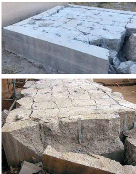
Рисунок 6. Разрушенный фундамент
